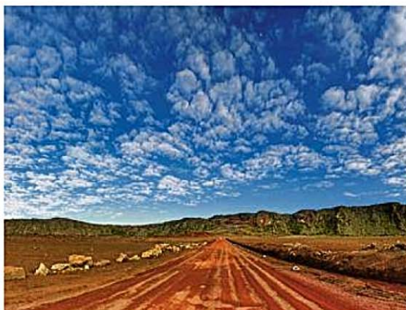
LE PROJET DE CONSTRUCTION de la nouvelle route du littoral à la Réunion au cœur d'un litige entre la Région et une société évincée du marché. Photo Shutterstock
